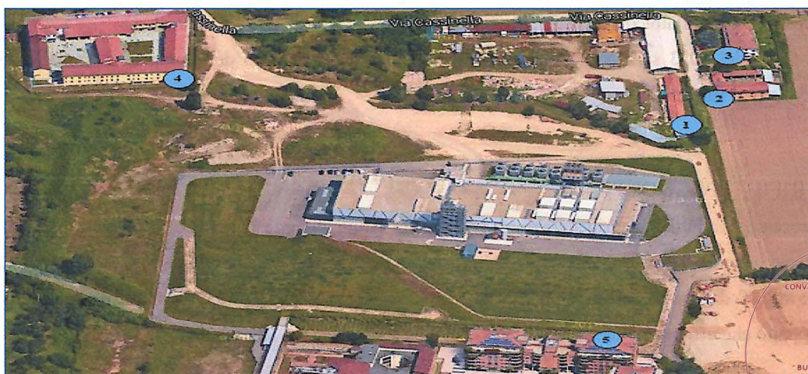
Figura 11 – Vista dall'alto della CCT. In evidenza i punti dove sono state effettuate le rilevazioni
