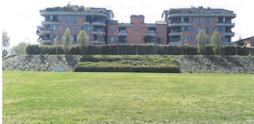
Figura 13 - Veduta dall'Impianto verso il lato Sud
