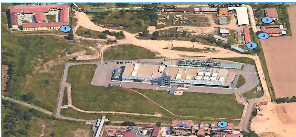
Figura 12 – Vista dall'alto della CCT. In evidenza i punti dove sono state effettuate le rilevazioni
